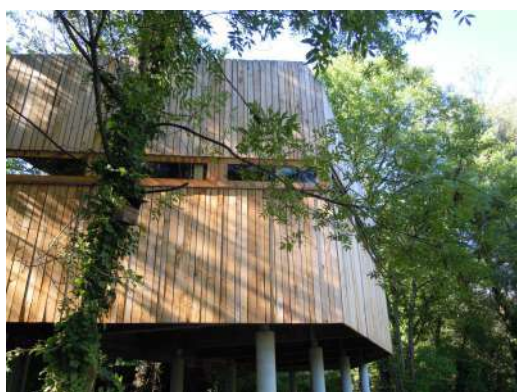
1 ER OBSERVATOIRE AVANT TRAVAUX
