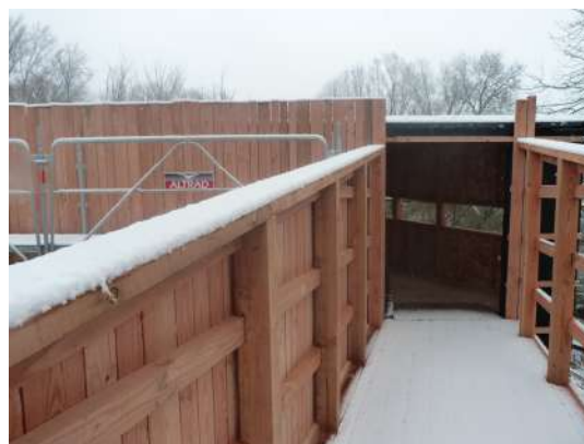
1 ER OBSERVATOIRE PENDANT TRAVAUX
